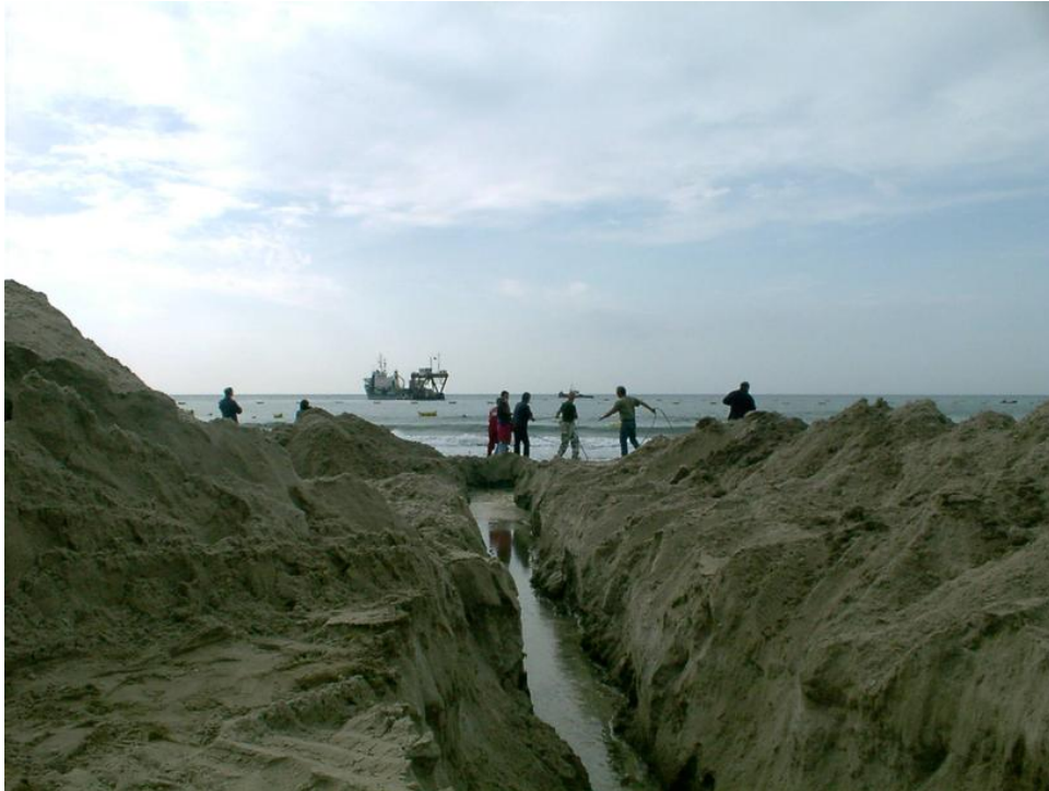
Figure B-18 : photographie montrant la fin du déploiement du câble électro-optique sur la plage des Sablettes à la Seyne-sur-Mer.
