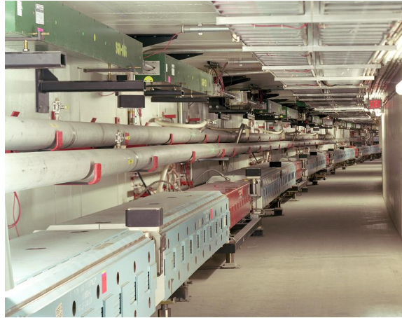
FIGURE 2.6 – Photo de l'injecteur principal (aimants du bas en bleu et rouge) et du recycleur (aimants du haut en vert).
