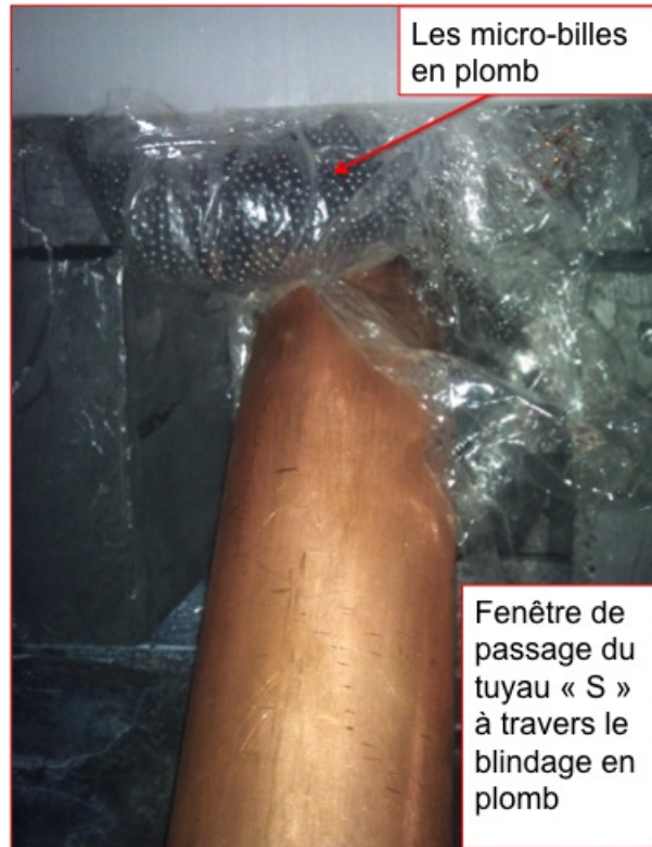
FIGURE 7.3 – Fenêtre de passage du tube en « S » remplie de micro-billes en plomb.
