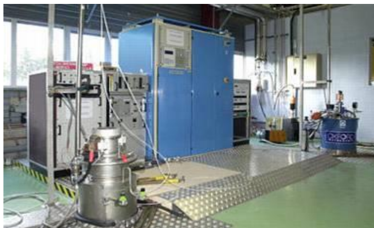
Figure II-1 : Vue des stations d'essais du service dédiées aux mesures de courant critique, à gauche Christiane, à droite Cétacé, en arrière-plan les baies d'instrumentations ainsi que l'alimentation de courant, en bleu, Hazemayer de 3 000 A.
