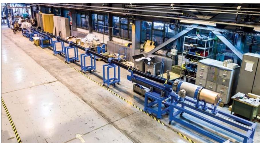
Figure I-12 : Vue de la station de test du câble de courant prototype (2x20 m et 20 KA) au CERN
