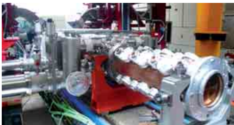
Début du montage du système de pompage sur le RFQ.
