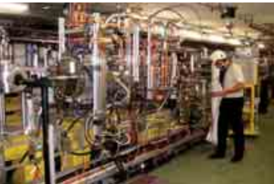
Banc de test à deux faisceaux dans le hall d'expérience de CTF3 au Cern (crédit Cern).
