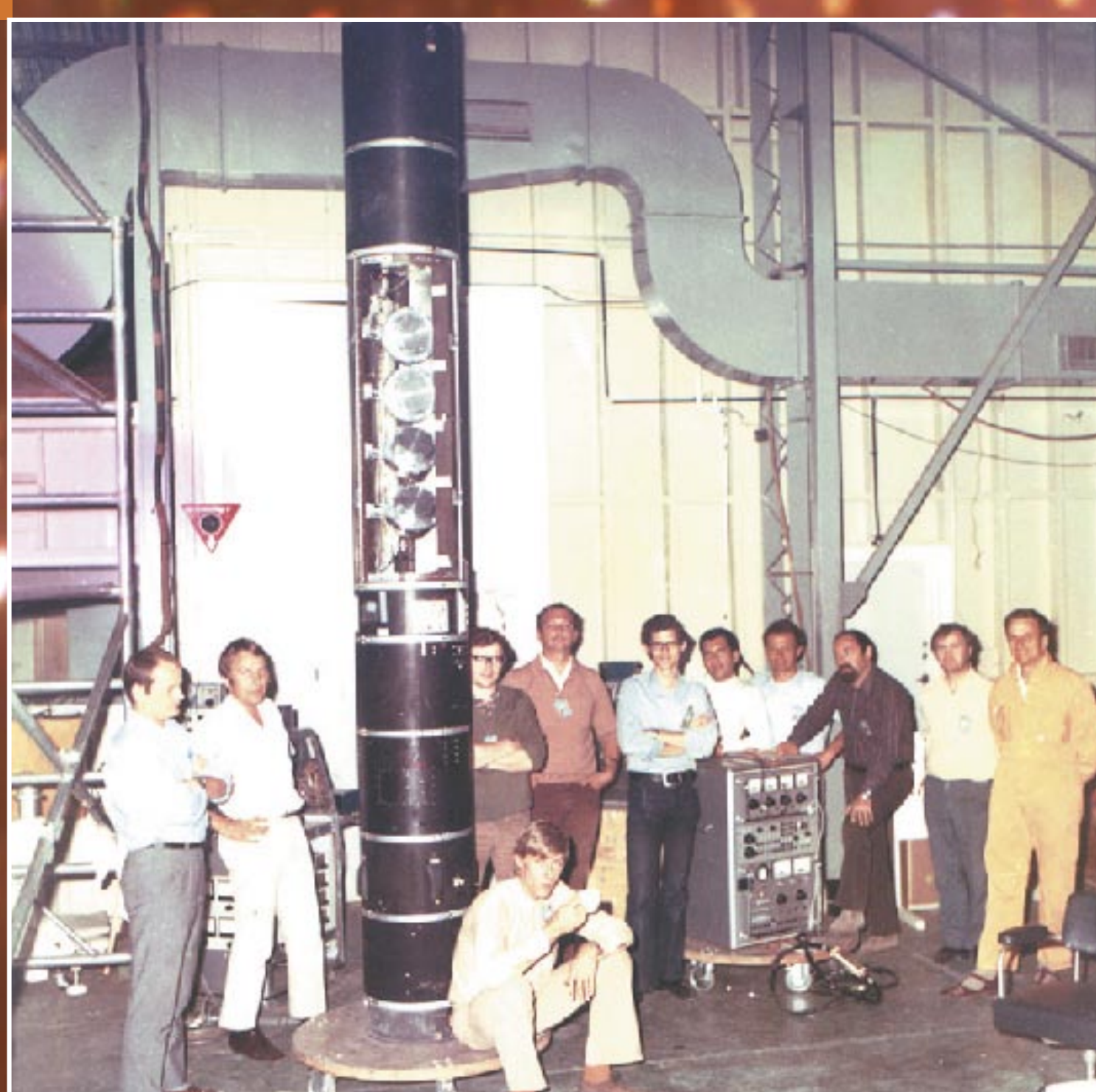
Détecteurs « compteurs proportionnels » construits au CEA pour la détection par fusée des rayons X cosmiques
