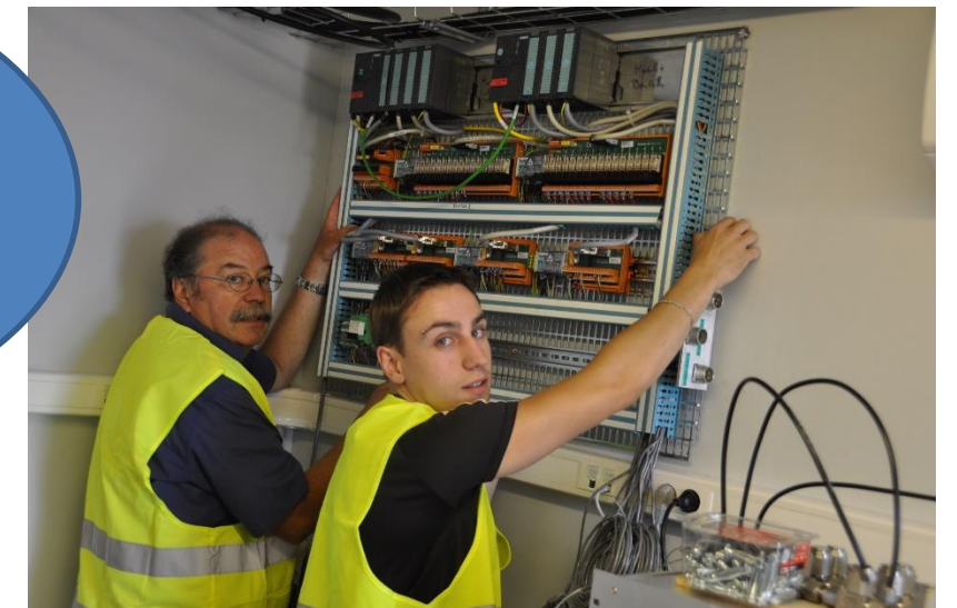
Juillet 2011 Installation des équipements process
