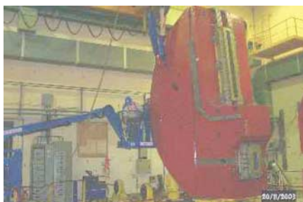
Manutention lourde sur le spectromètre 600 (plus de 100 t) de HE1, l'une des salles expérimentales de l'ALS.
