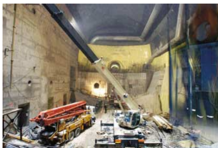
Caverne de CMS en cours d'excavation, à 90 mètres sous terre.
