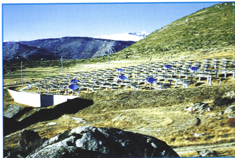
Vue d'ensemble du site de Thémis. On distingue les 7 miroirs du télescope ASGAT répartis parmi les 210 héliostats de la centrale solaire.
