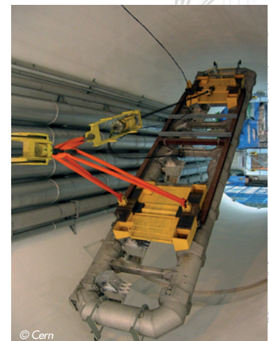
Descente d'une bobine d'Atlas dans la caverne, 100 m sous terre.
