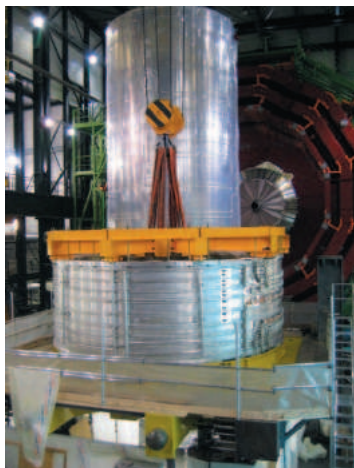
Mise en place du premier module du solénoïde supraconducteur CMS sur la plateforme de montage au CERN.
