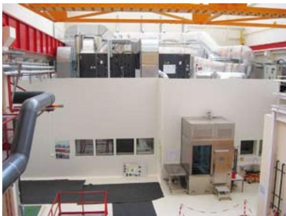
Le nouvel ensemble de salles blanches du SACM, vu de l'extérieur. On observe le système d'aspiration sur la partie supérieure et la cabine de lavage ISO 4 au centre.
