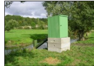
Stations de suivi des eaux
