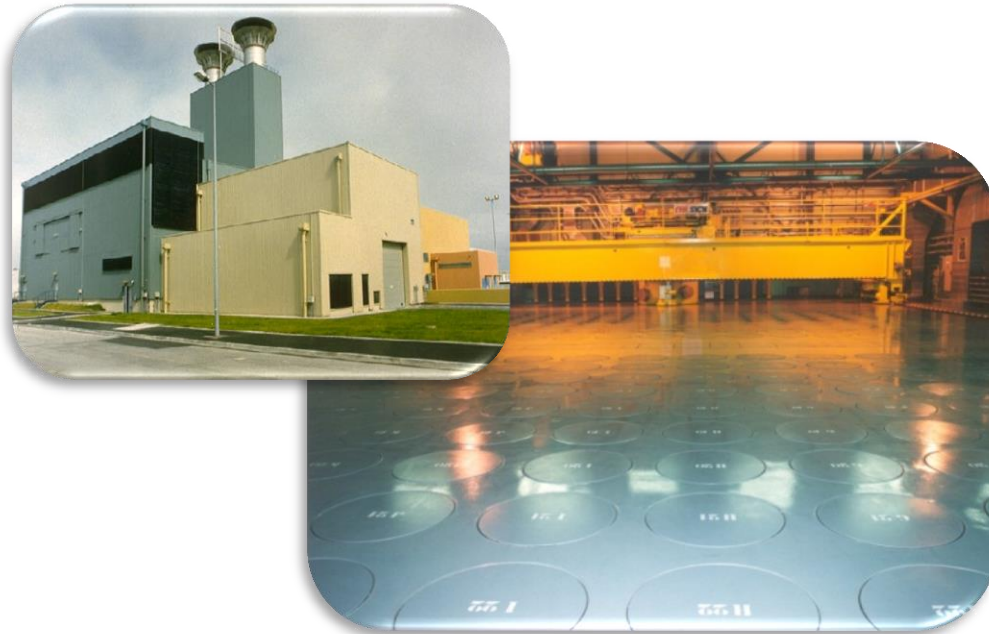
Entreposage des colis vitrifiés, Areva
