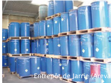
Entrepôt EIP pour les fûts d'enrobé bitumineux de Marcoule (CEA)
