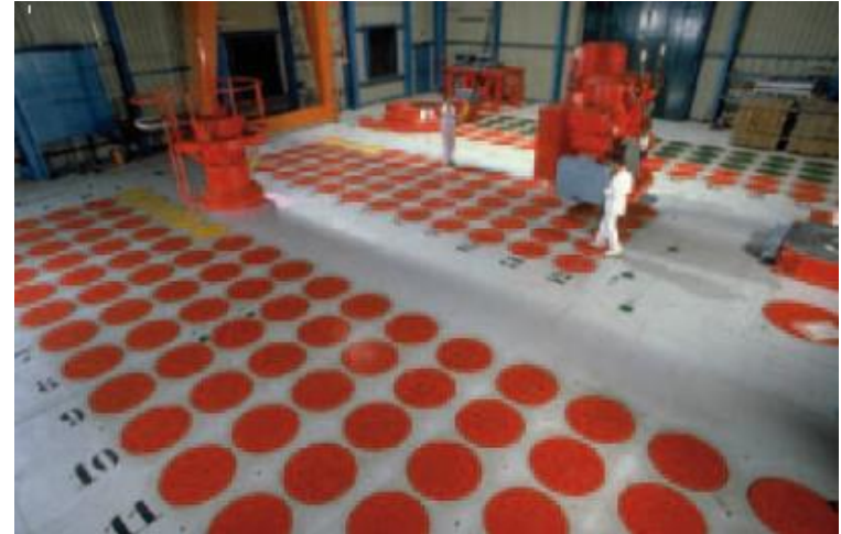
Entreposage des AVM à Marcoule
