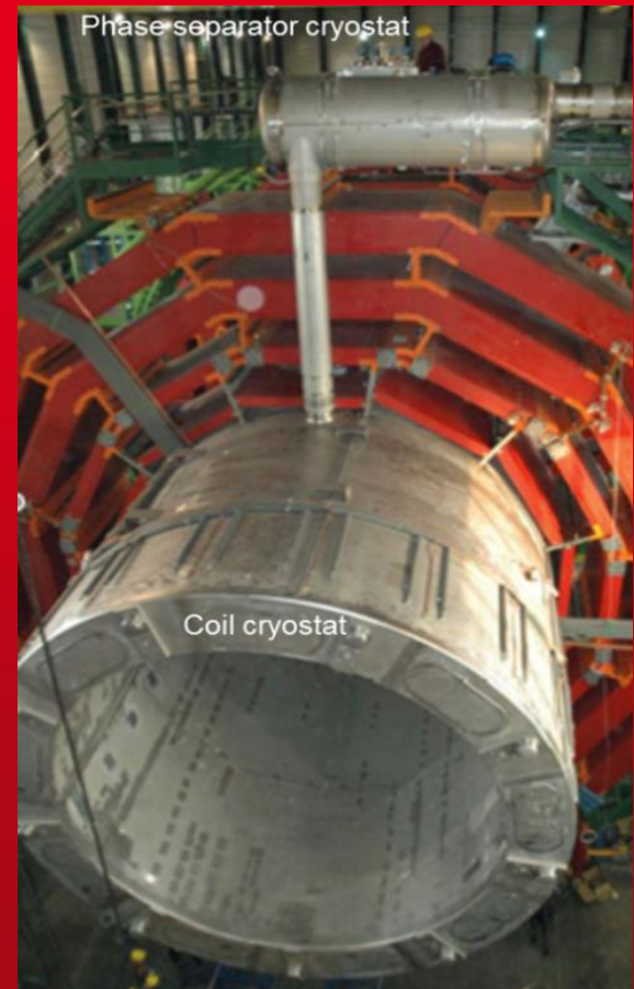
Système de refroidissement de CMS
