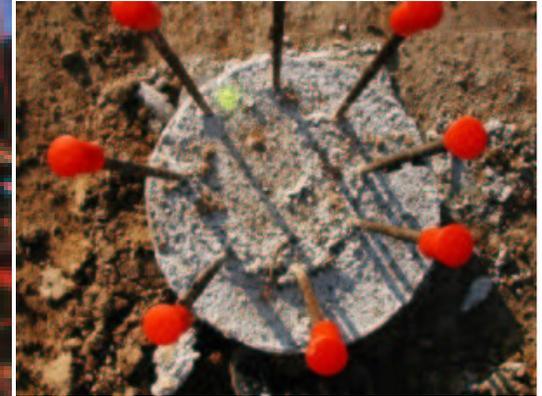
Afin de garantir la stabilité de l'anneau et des expériences, les accélérateurs et le hall d'expérimentation reposent sur des **pieux** en béton, ferrillés et ancrés à **15 mètres** de profondeur, dans la couche stable des sables de Fontainebleau.
