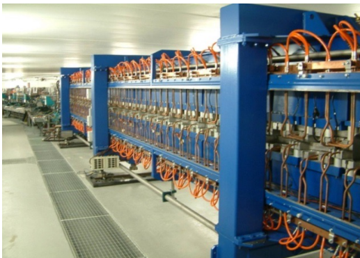
HU 640 : ligne DESIRS (5 eV – 50 eV : Ultra Violet)
